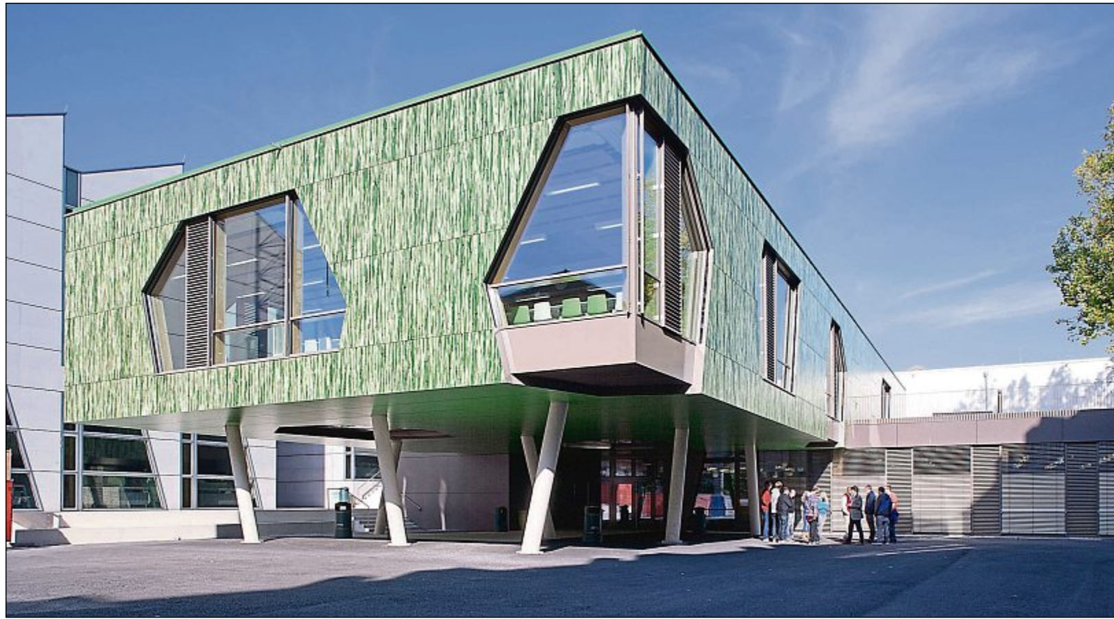
Der Neubau mit Mensa und Cafeteria sowie einer Sporthalle.
