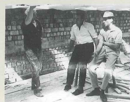
Anfänge auf der Baustelle. Anfang der 60er-Jahre war noch viel Improvisationstalent im Trockenbau gefragt.
