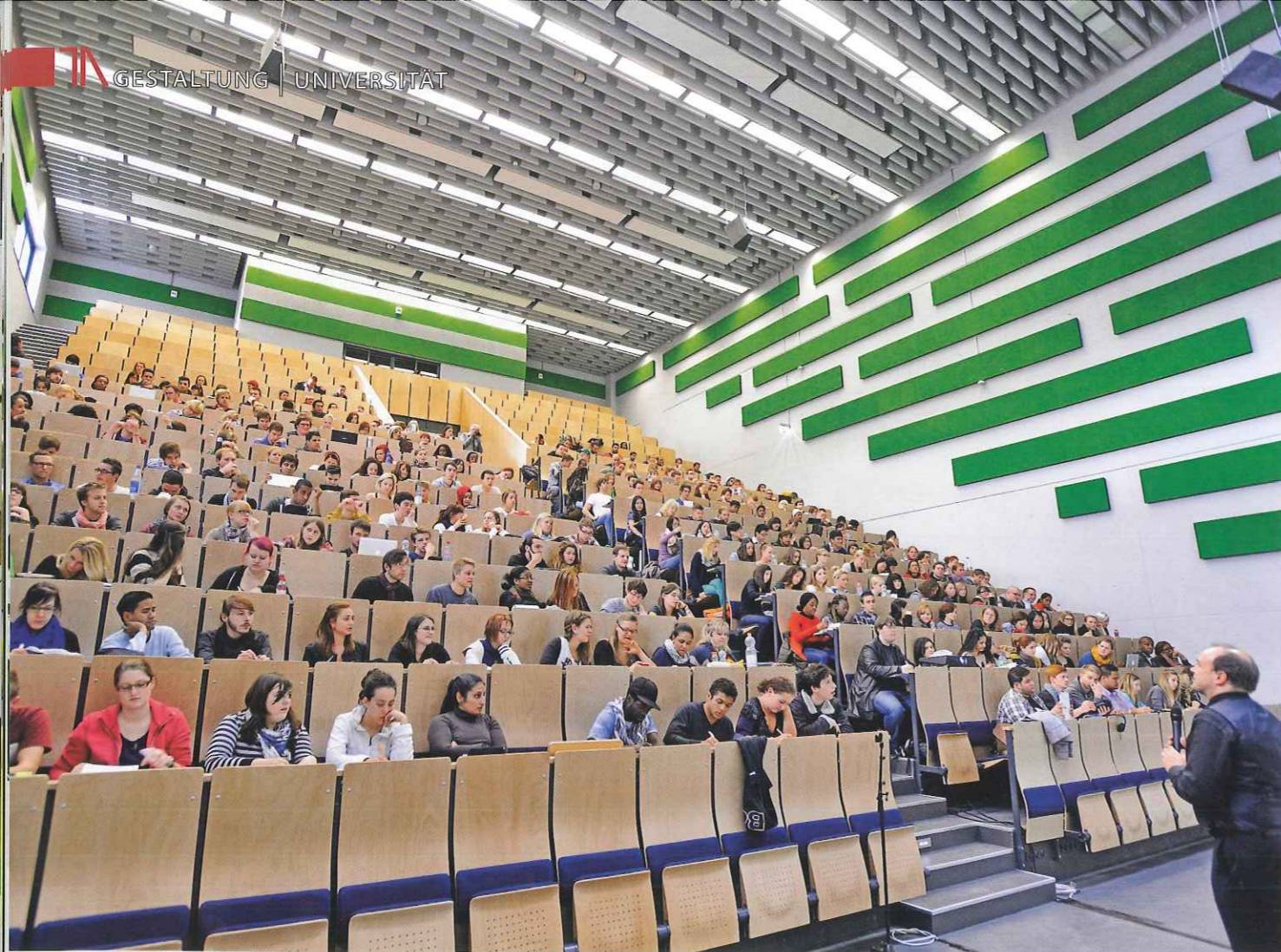
Hochschule Rhein-Waal. Eine moderne betonkernaktivierte Decke muss „atmen“ können. Daher kam die Möglichkeit einer klassischen, abgehängten Akustikdecke nicht infrage. Eine Baffeldecke löst Probleme gleich in mehrfacher Hinsicht.
