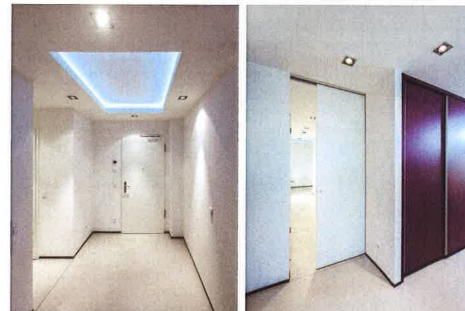
Vorsatzschalen an den Wohnungstrennwänden verbessern den Schallschutz und nehmen die Küchenzeile auf. Deckenfelder mit indirekter Beleuchtung in den Fluren verleihen den Wohnungen ein edles Entree. Schiebetüren in den Trockenbauwänden sorgen für die optimale Ausnutzung der Flächen (Fotos: Knauf/Bernd Ducke)
