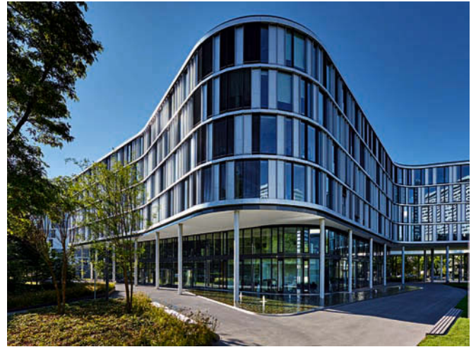
Maximal offene Fassade für freien Parkblick • Open façade for an view of the park
